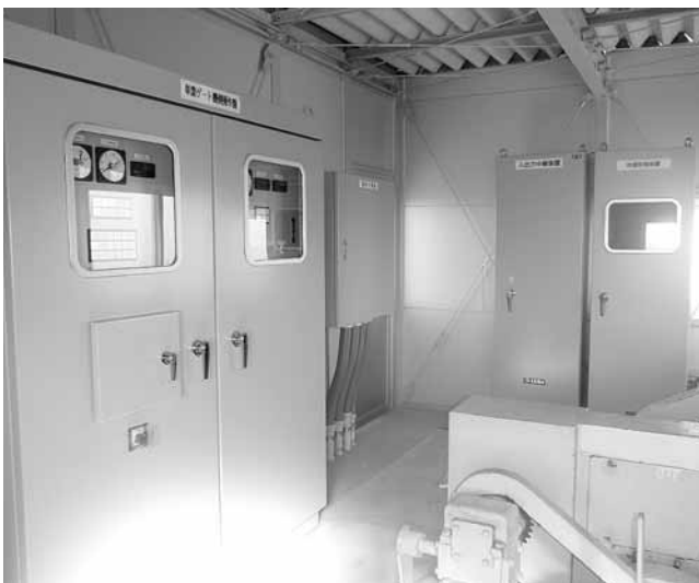
<八間堰操作室>
